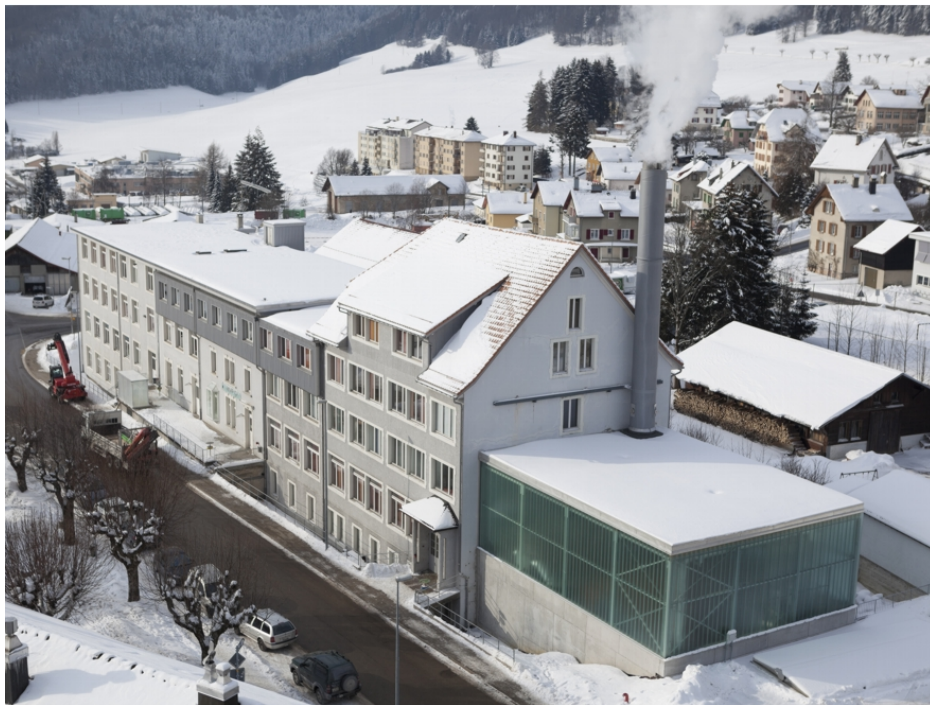
Figure 2 : les réseaux de chauffage à distance permettent une valorisation optimale du bois-énergie sous forme de plaquettes, à la fois d'un point de vue écologique et économique. Exemple : au premier plan, la centrale de chauffage CROIXCAD. (Source : Commune de Sainte-Croix)
