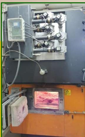
Chaudière à plaquettes de 360 kW.
