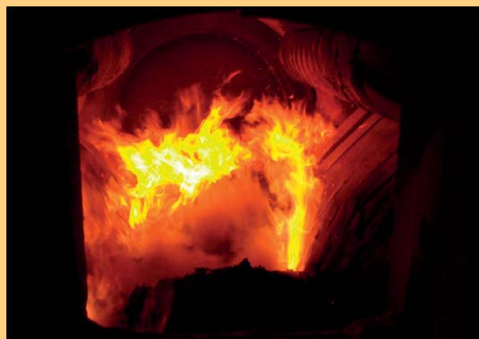
Manque d'air avec développement de fumées (ardens GmbH, 2017).
